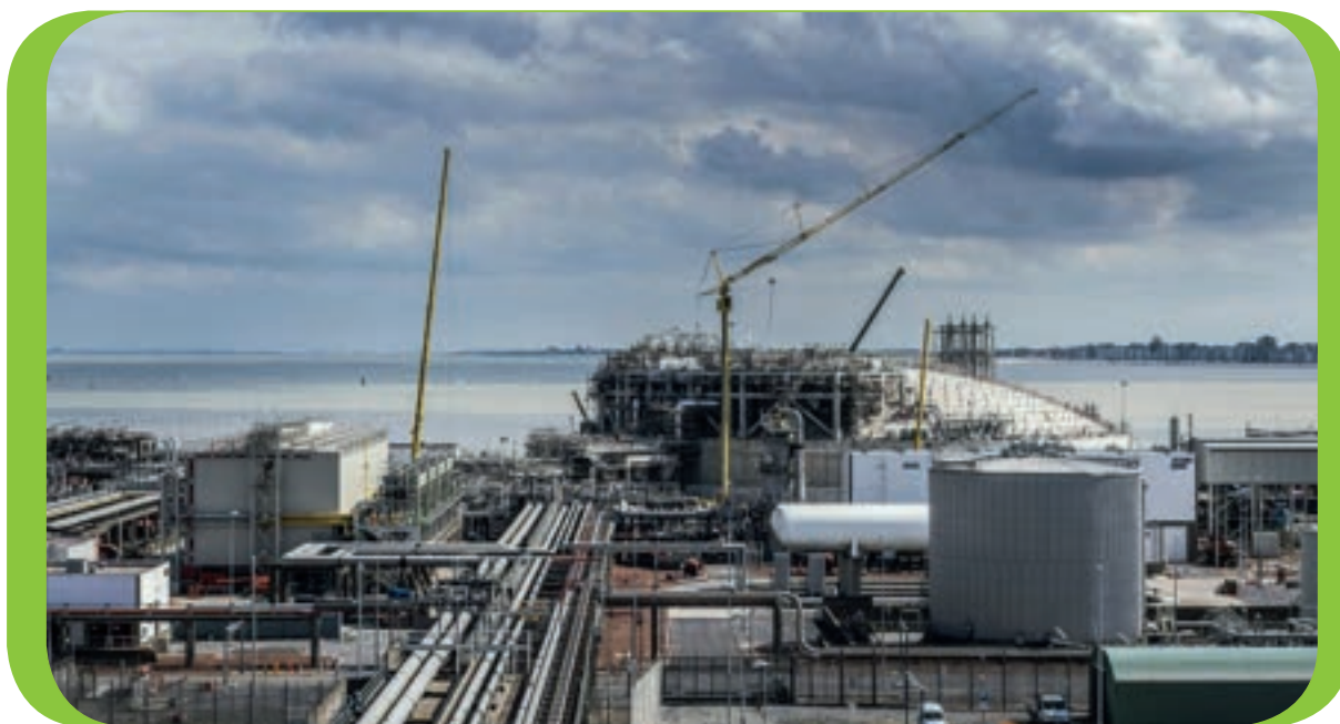
LNG terminal Brugge
