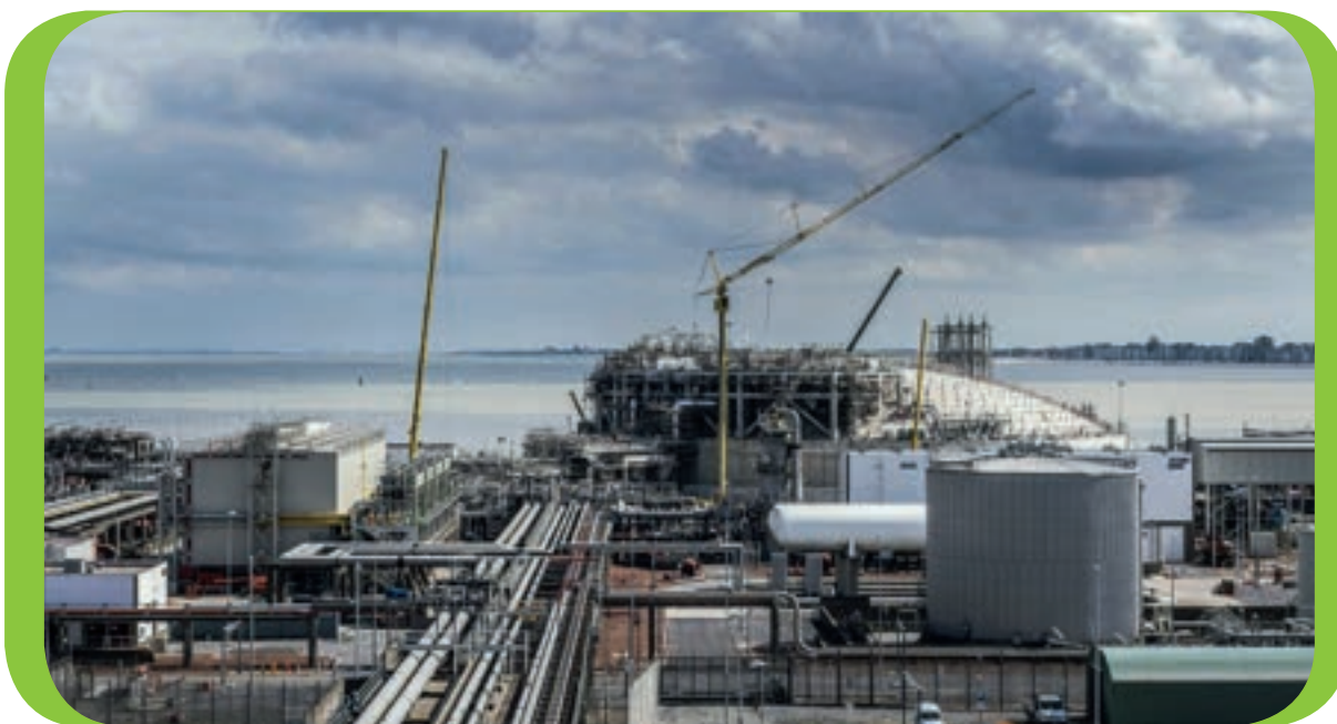
LNG terminal Brugge
