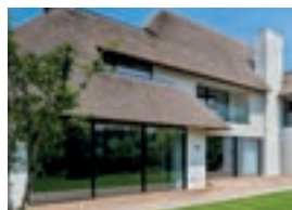
VRANKEN RIETEN DAKEN
