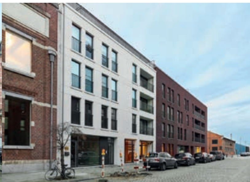
Project 'Cadixdok': 31 appartementen en 4 handelsruimtes aan het Eilandje in Antwerpen
