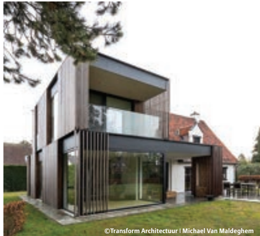
©Transform Architectuur | Michael Van Maldeghem
