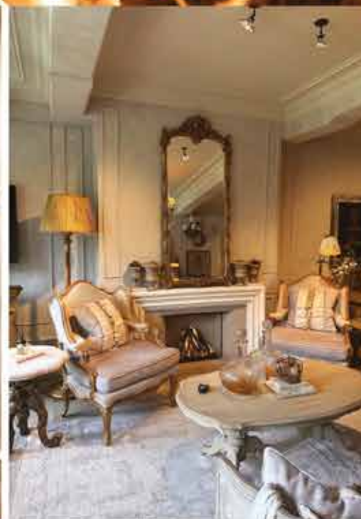
Ultra View 650/730 - gesloten gashaard met mortex look afwerking © The Notary Hotel Bruges
